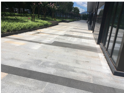
建筑周边地表硬化铺装 1
