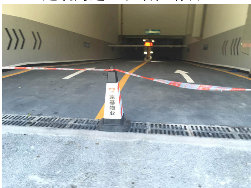
地库出入口硬化及排水设施
