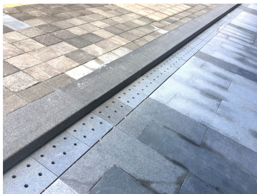
区内路面雨排水设施 6
